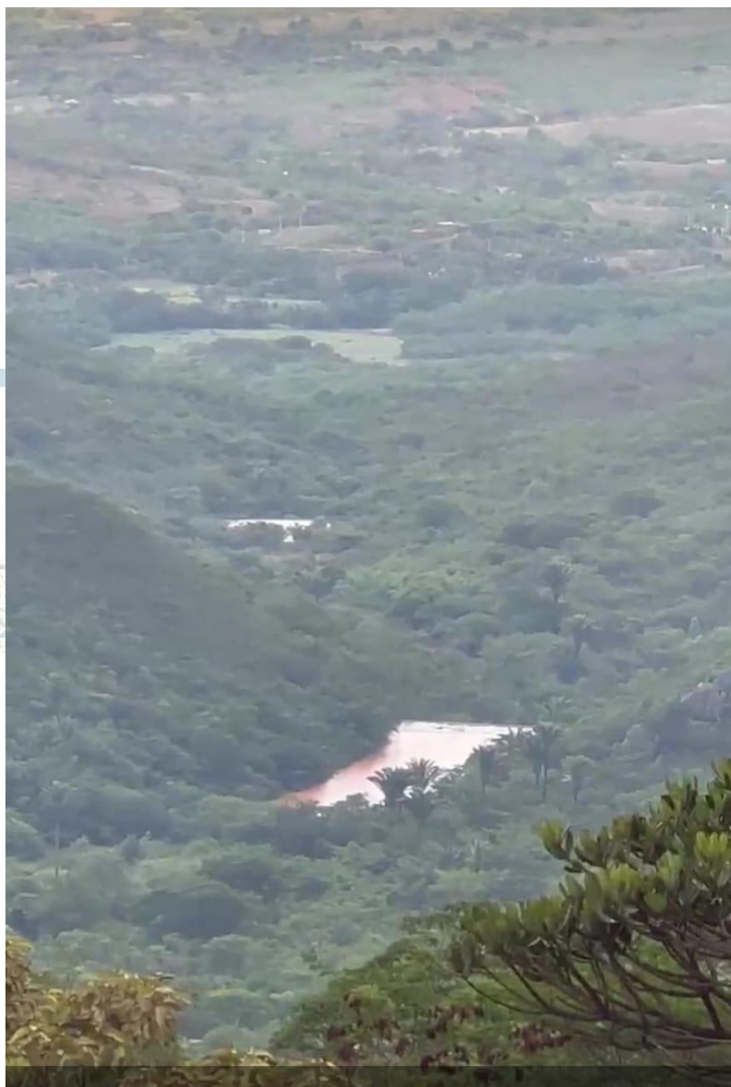
Figura 05: Foto da Barragem vista pela Área do Parque após o ocorrido
